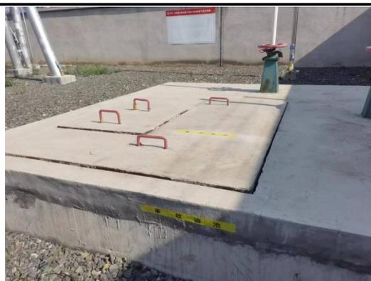
220kV 变电站内新建事故油池 (60m<sup>3</sup>)
