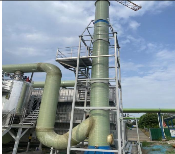
图 3-7 南片污水预处理区排口 P3
