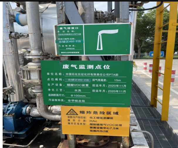
图 3-4 总罐区废气排口 P2
