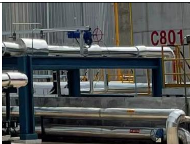
图 3-15 罐区围堰设置情况
