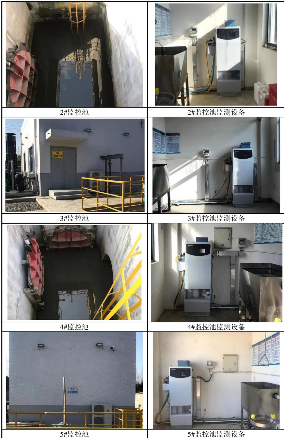
图 3.2-7 雨水排口监控池及监测设备照片
