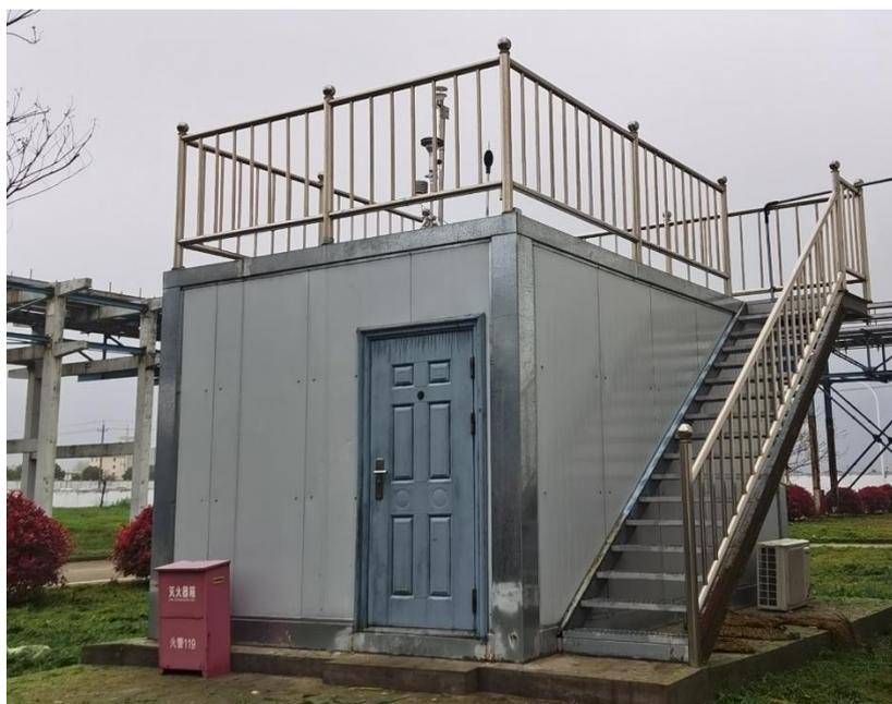
图 3.3-7 BDO 部 VOCs 无组织废气在线监测设备照片
