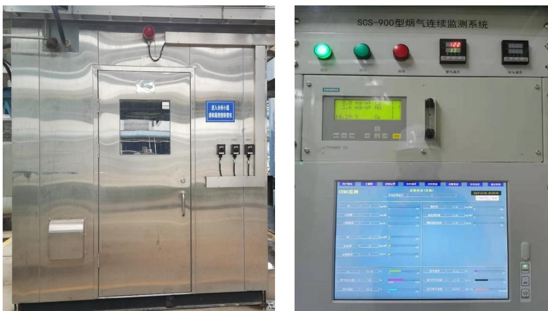
图 3.3-6 马来酸酐装置废气焚烧炉废气出口在线监测设备照片
