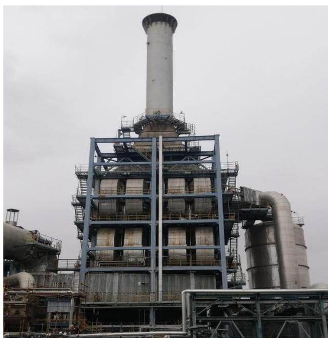
图 3.3-4 马来酸酐装置废气焚烧炉照片
