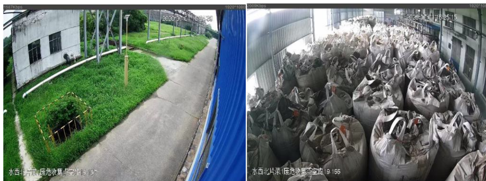
水务部危险废物收集点 2
