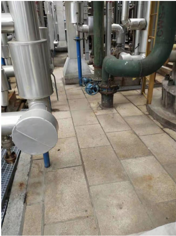
装置地面大理石防腐蚀、防渗措施
