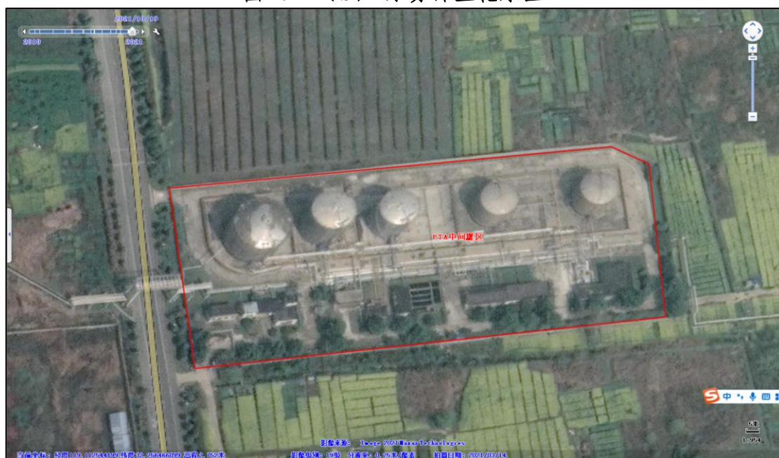
图 4.2-1 (c) PTA 中间罐区
